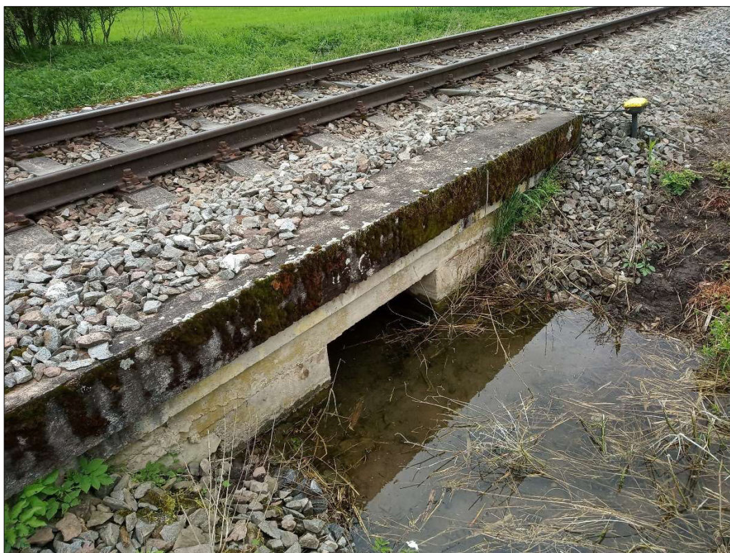
Obr. 13: Propustek v drážním km 6,759 určený k rekonstrukci
