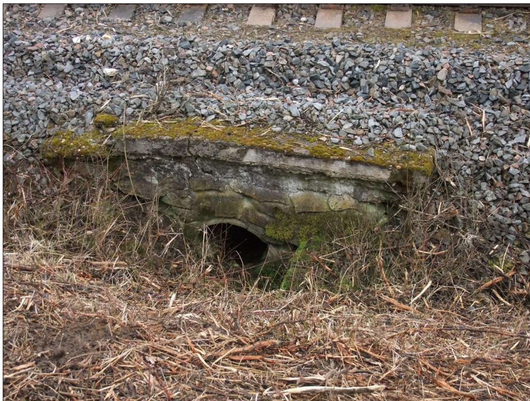
Obr. 14: Propustek v drážním km 9,215 určený k rekonstrukci
